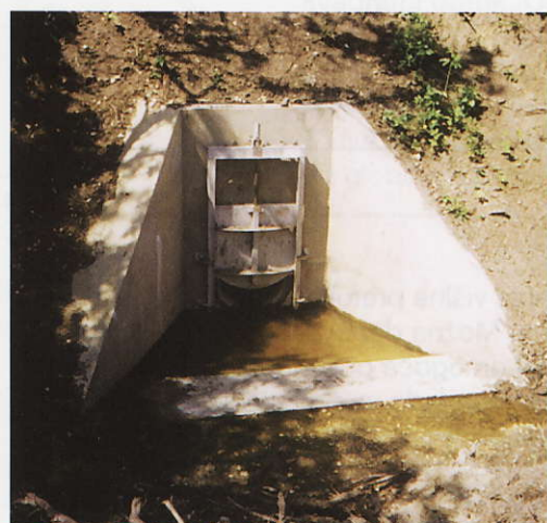
◀ EROX Loputa z vretenom na protipoplavnem nasipu
