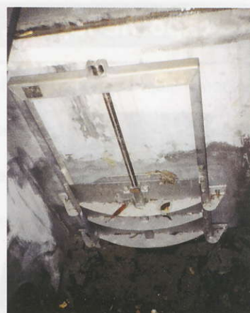
EROX Loputa z vretenom na čistilni napravi
