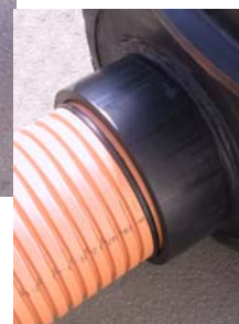
Priključitev PVC rebraste cev
