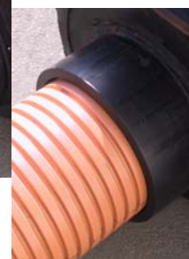
Pravilno izveden vstopni priključek
