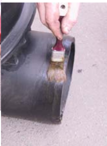
Mazanje roba stopničastega nastavka . . .
