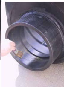
. . . mazanje vstopnega priključka
