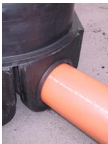
Priključitev cevi v vstopno tesnilo – izveden vstopni priključek
