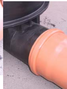
Priključitev PVC cevi
